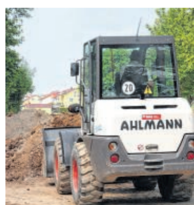
Noch türmt sich auf dem Parkplatz des Freibads das Baumaterial.
